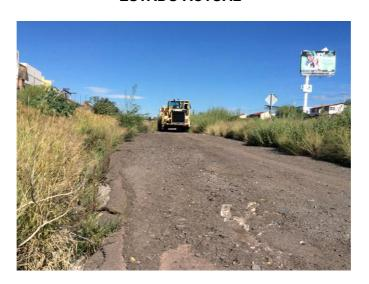
1. Aplicar DU-ROC® DRY + TEPETATE (si fuera necesario) y mezclar con Recuperadora
