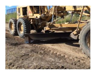
5. Compactar vibrando. Fin del proceso de REPARACION con SISTEMA DU-ROC® REPAIR.
