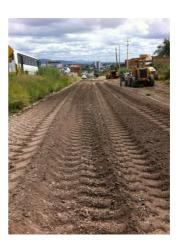
3. Rociar superficie con agua (cantidad = Humedad óptima) + DU-ROC LIQUID  $^{\circledR}$  y mezclar.
